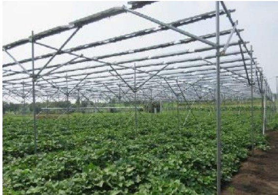
露地の畑の上部にパネルを設置
