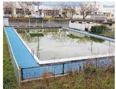
久原小学校プール 本年度ろ過機交換予定
