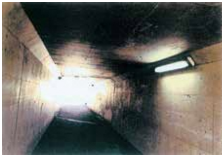
下久原・深井交差点付近地下道 蛍光灯を24時間点灯へ
