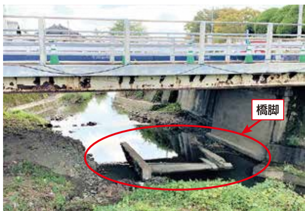
橋脚が崩落した現場
