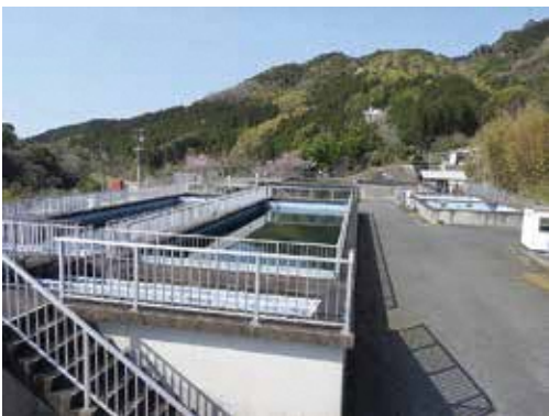
久山町浄水場
