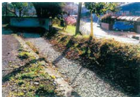
公園内排水路
