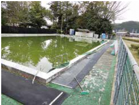
山田小学校プール 4～5年前ろ過機交換
