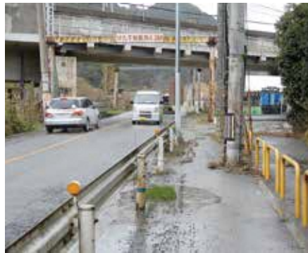
福岡市側から見た歩道要望箇所
