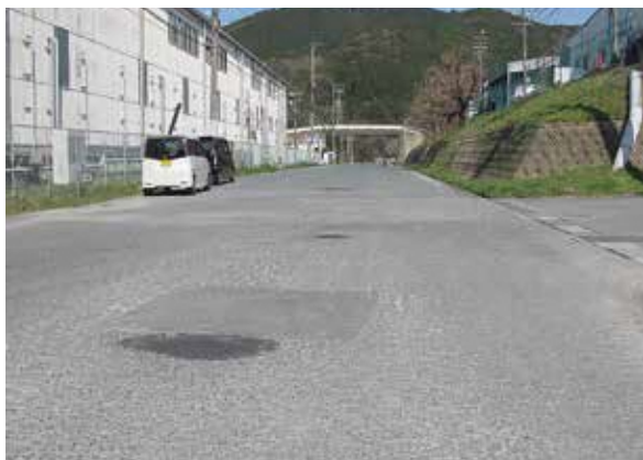
赤坂工場団地1号線舗装打替箇所
