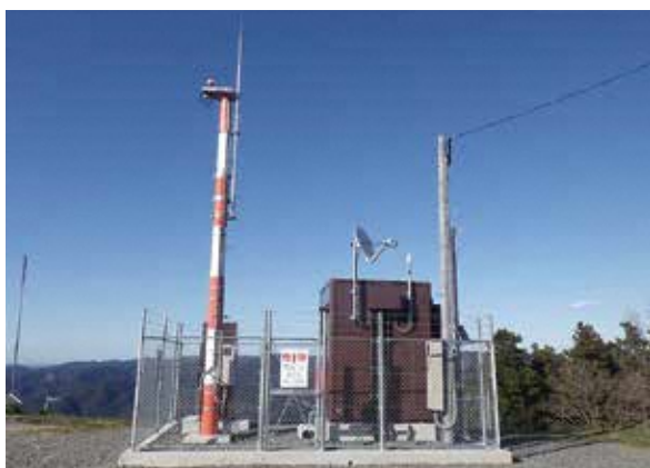
防災無線設備 (篠栗町 米ノ山送信局)
