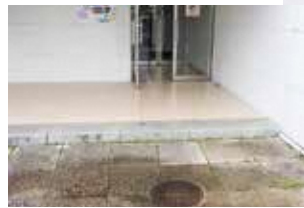
役場西側玄関の段差
