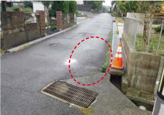
陥没した箇所
