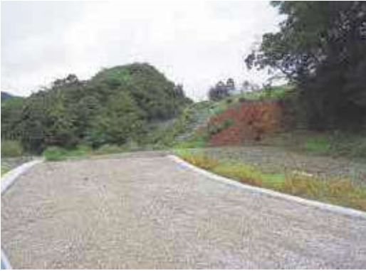
▲2期工事地から3期工事予定地を望む
