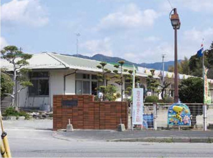
▲解体される山田幼稚園
