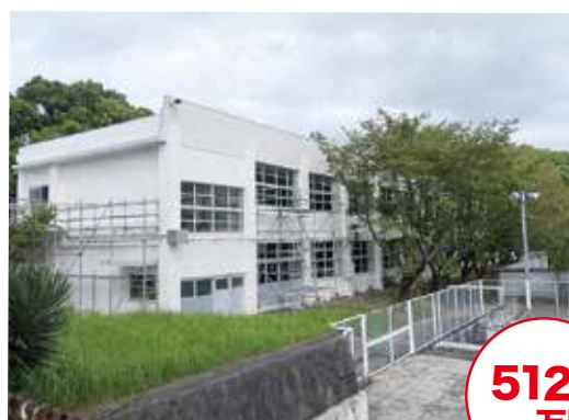
久 山中学校特別教室棟改修工事
