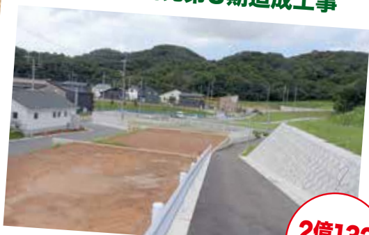
草 場地区再開発第3期造成工事
