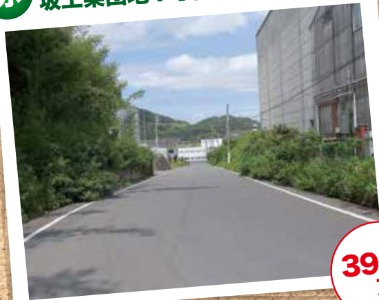
赤 坂工業団地1号線舗装打替工事
