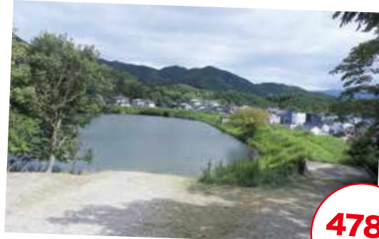
草 場池堤体改修工事
