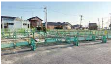
工事中の猪野バス停の様子
