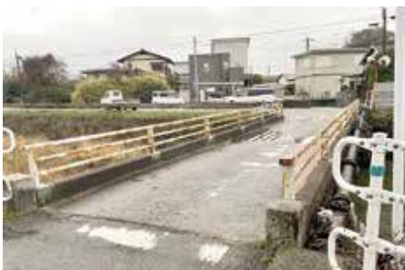
横手橋 (右岸側から)
