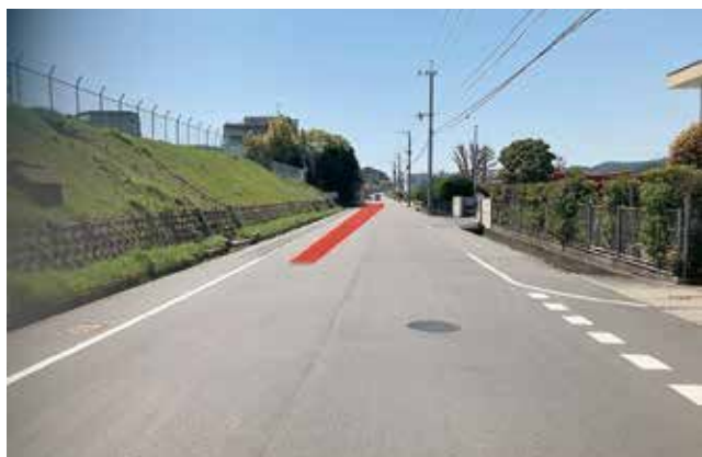
①猪野地内下水道築造工事 (43 工区) 赤坂工業団地内
