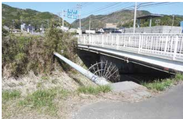
②首羅橋配水管移設工事
