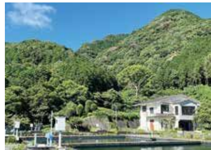
久山町浄水場
