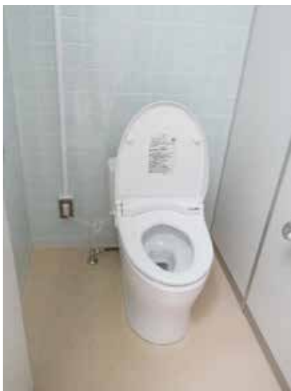
山田小学校の温かい便座完成の写真
